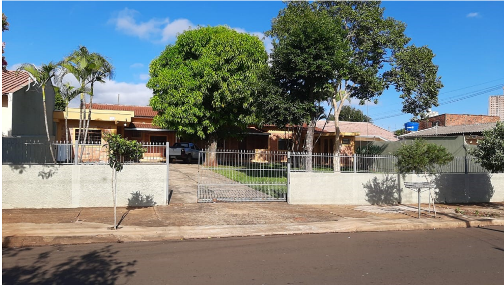
Figura 1 - Frente do imóvel
