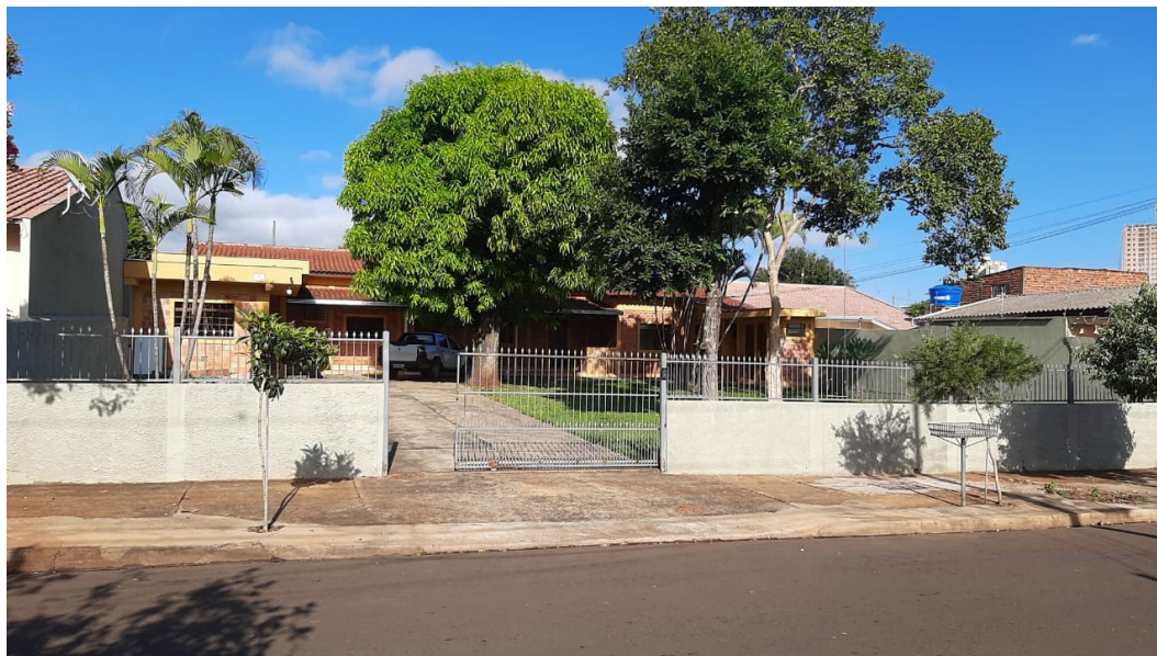
Figura 1 - Frente do imóvel
