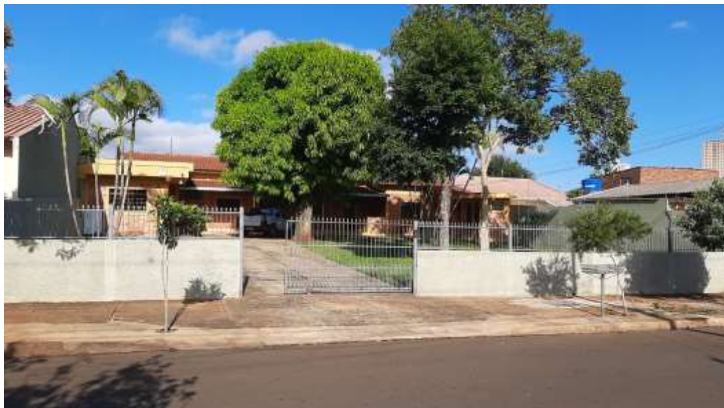
Figura 1 - Frente do imóvel
