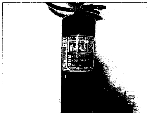
Figura 8 - 06/05/2019 – Extintor ABC 6kg recepção
