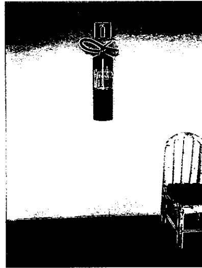
Figura 4 - 06/05/2019 – Extintor ABC 10kg na recepção
