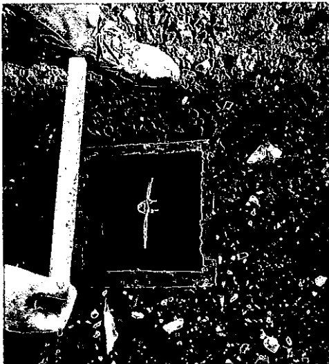
Figura 3 - 06/05/2019 – Aterramento SPDA
